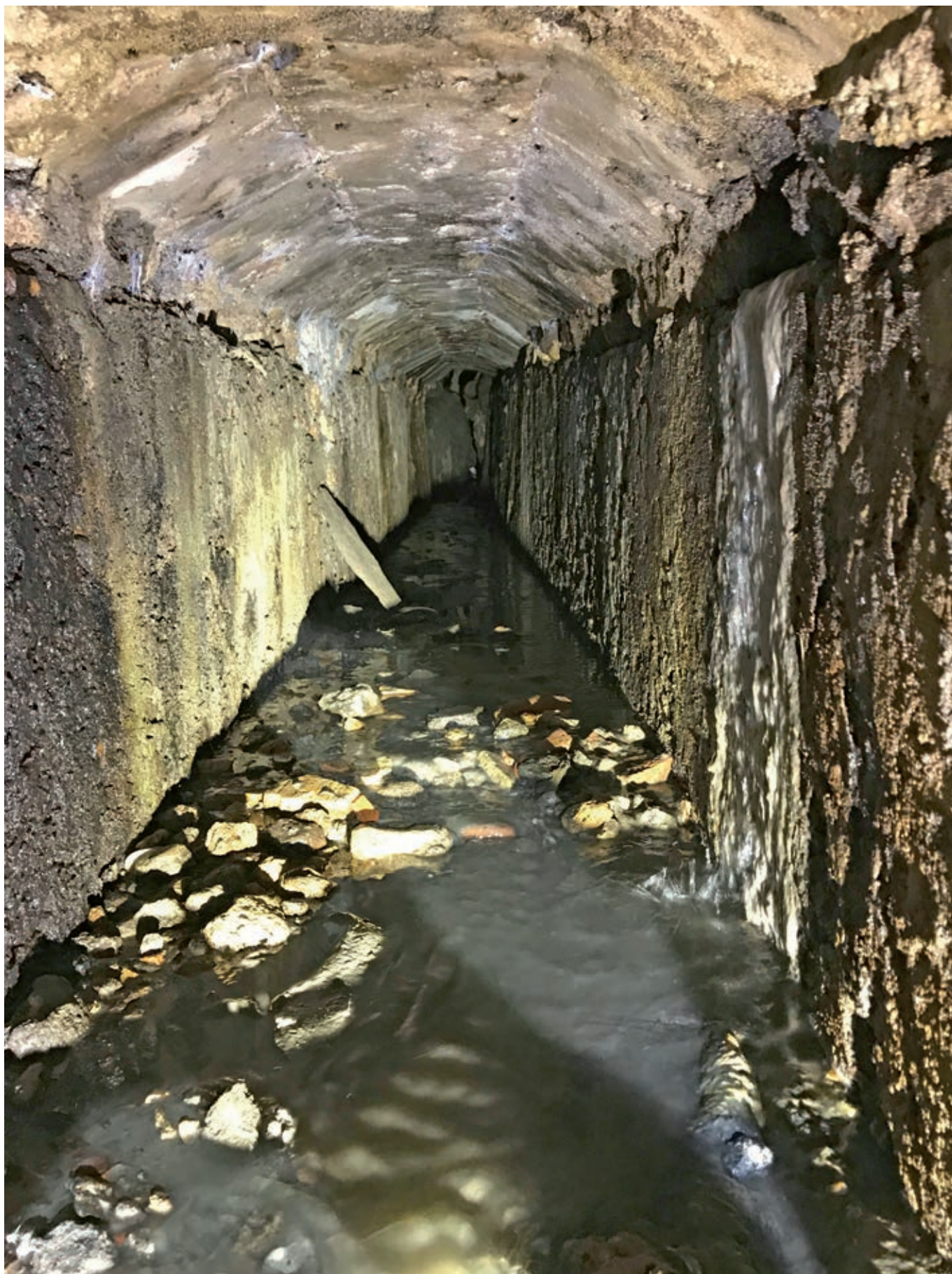
Fig. 20 – Cunicolo di Bagno, porzione iniziale del condotto (foto A. Schatzmann) Fig. 20 – Bagno conduct, first section (photo A. Schatzmann).
