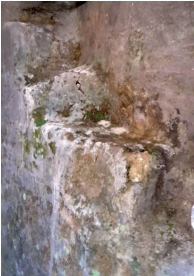
Fig. 5 – La cisterna della Cattedrale: particolare delle tracce di una probabile scala di accesso (foto C. Germani).
