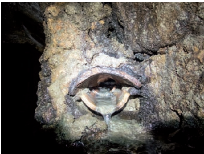
Fig. 22 – Cunicolo di Bagno, canalizzazione realizzata con coppi affrontati (foto S. Cretin). Fig. 22 – Bagno conduct, water outlet created with two tiles turned against each other (photo S. Cretin).
