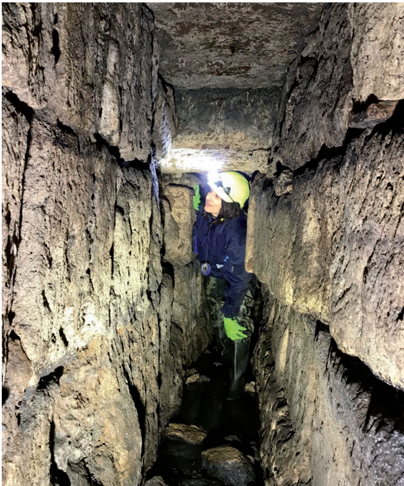
Fig. 13 – Cunicolo sotto il convento di Santa Chiara: tratti con copertura a lastroni (foto A. Schatzmann). Fig. 13 – Conduct under S. Chiara Monastery: section with big slabs covering (photo A. Schatzmann).
