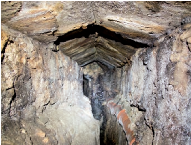
Fig. 21 – Cunicolo di Bagno, tratto con copertura a cappuccina, si noti la tubazione in terracotta sulla parete dx (foto S. Cretin). Fig. 21 – Bagno conduct, section with cappuccina covering. Note the terracotta tube on the right wall (photo S. Cretin).
