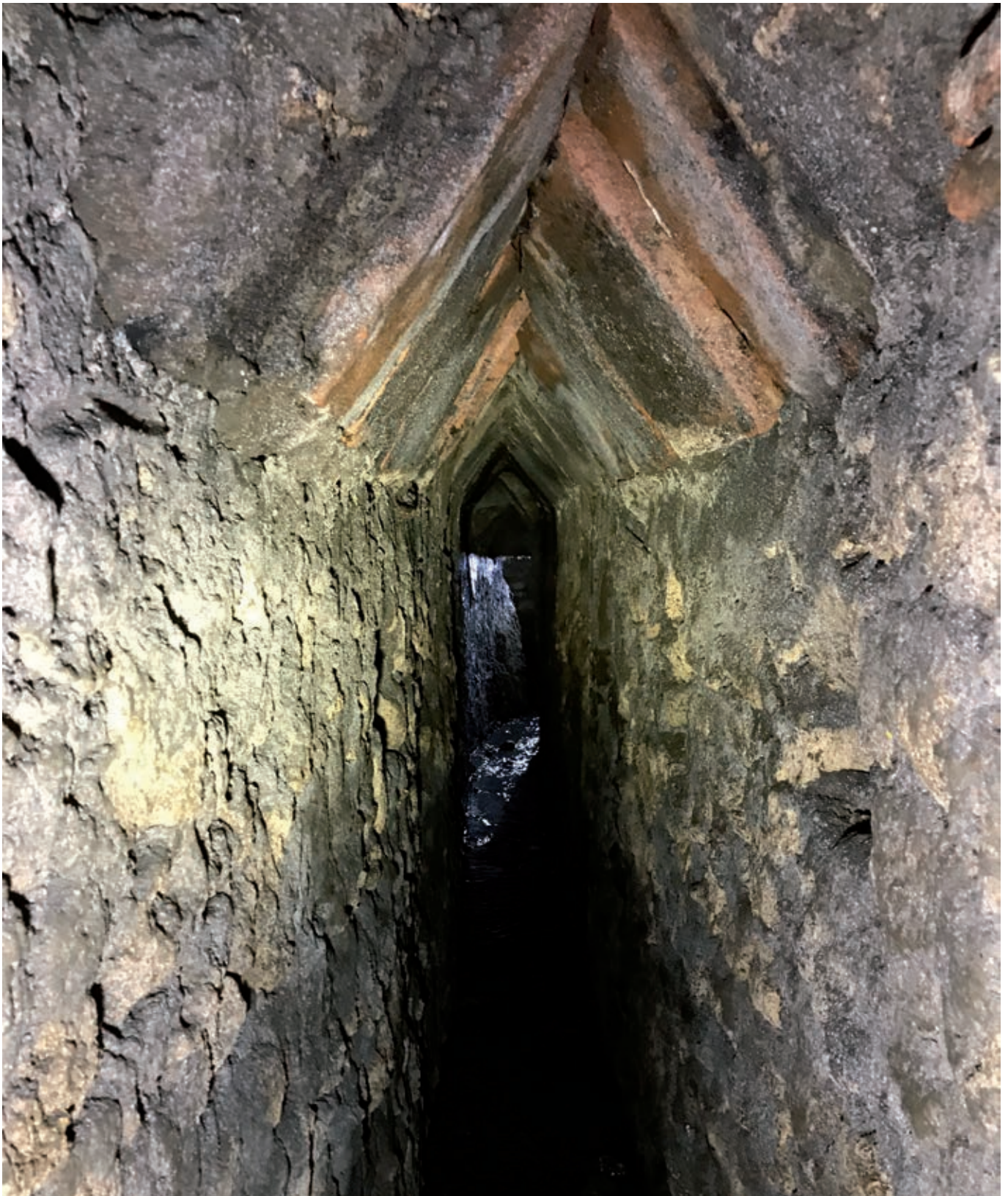
Fig. 14 – Cunicolo sotto il convento di Santa Chiara: tratti con copertura a cappuccina in laterizi rettangolari (foto A. Schatzmann). Fig. 14 – Conduct under S. Chiara Monastery: section with cappuccina covering with rectangular tiles (photo A. Schatzmann).
