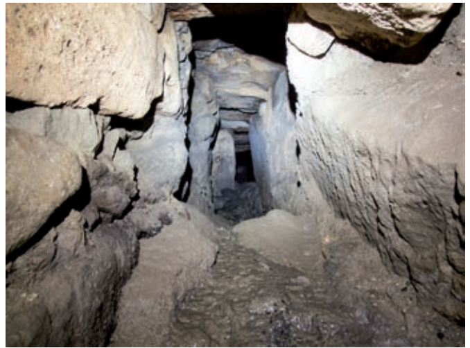
Fig. 23 – Cunicolo di Bagno, tratto con copertura a lastroni (foto S. Cretin). Fig. 23 – Bagno conduct, section with big slabs covering (photo S. Cretin).
