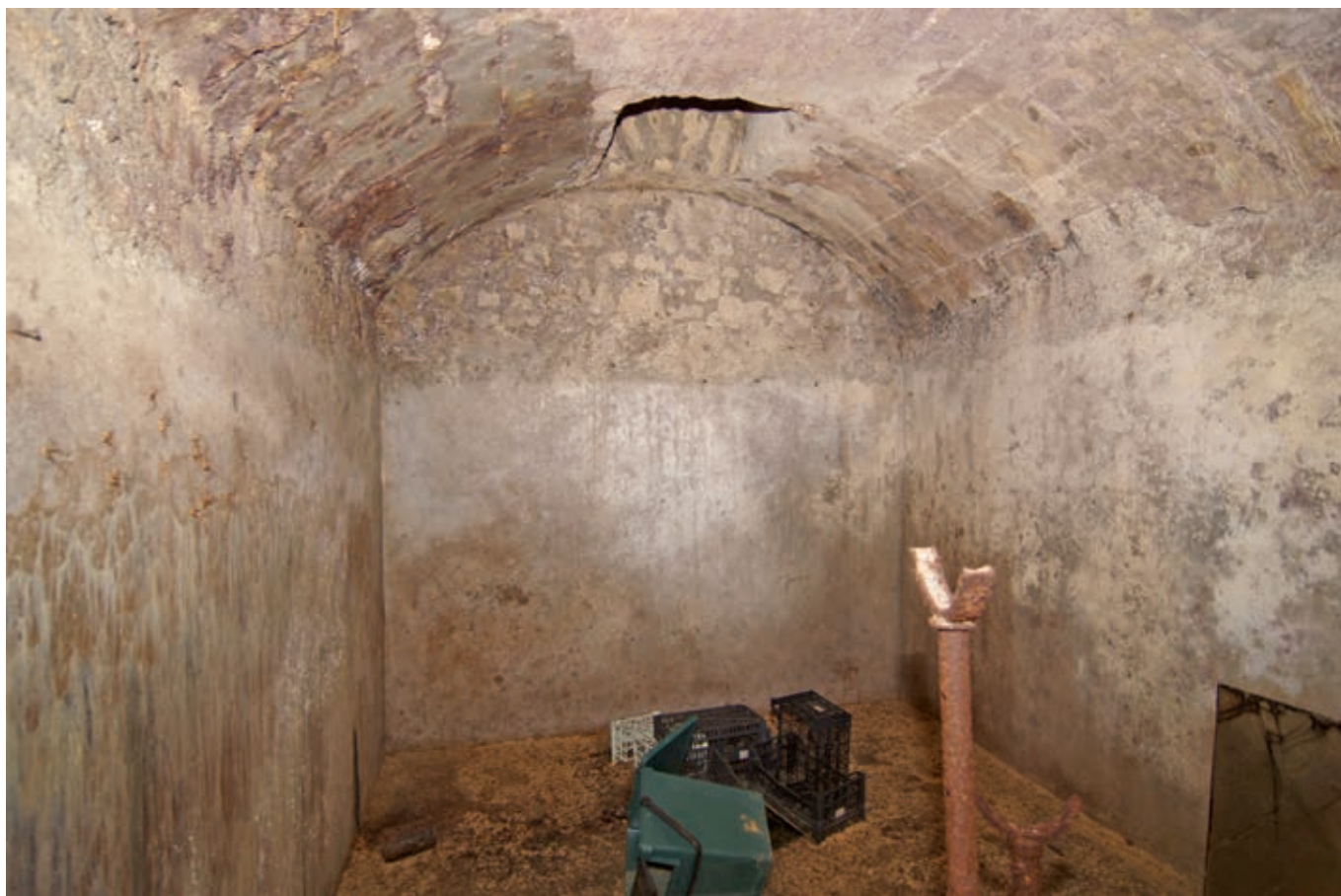
Fig. 33 – Cisterna sotto al negozio di Corso Vittorio Emanuele 214 (foto C. Germani). Fig. 33 – Cistern under the shop at Corso Vittorio Emanuele, 214 (photo C. Germani).
