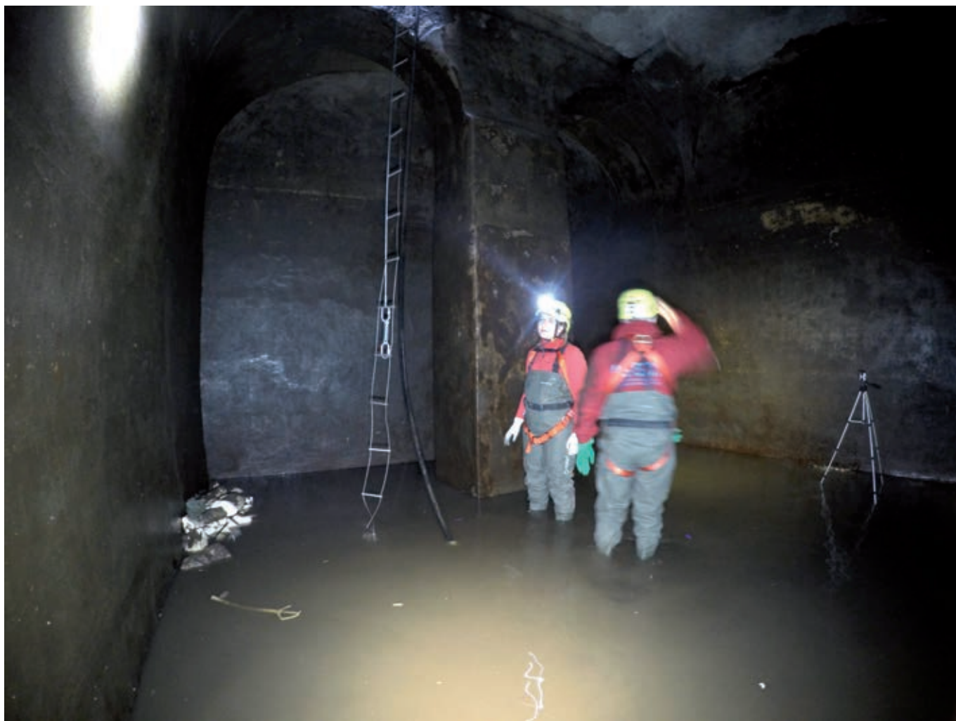
Fig. 7 – La cisterna sotto il complesso di Bonifacio VIII (foto C. Germani).
