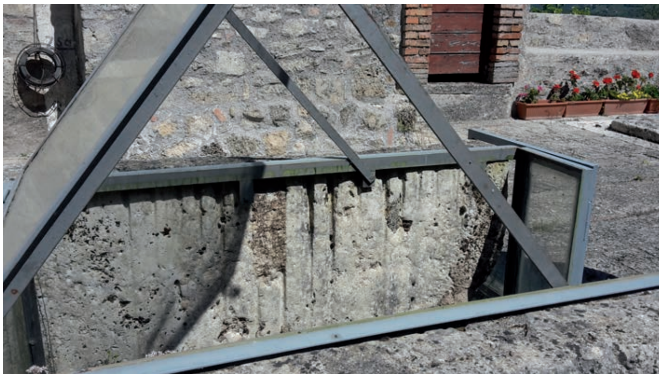
Fig. 4 – La cisterna della Cattedrale: tracce dei solchi lasciati dalle corde che venivano utilizzate per attingere l’acqua (foto C. Galeazzi).
