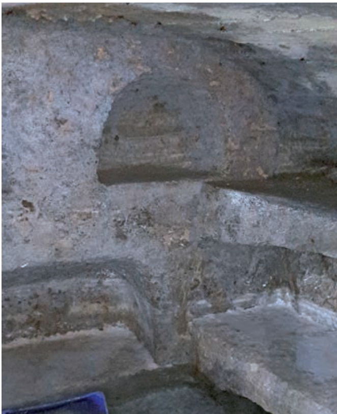
Fig. 32 – Ambiente laterale sommerso sotto al negozio di Corso Vittorio Emanuele 214 (foto C. Germani). Fig. 32 – Side room filled with water under the shop at Corso Vittorio Emanuele, 214 (photo C. Germani).
