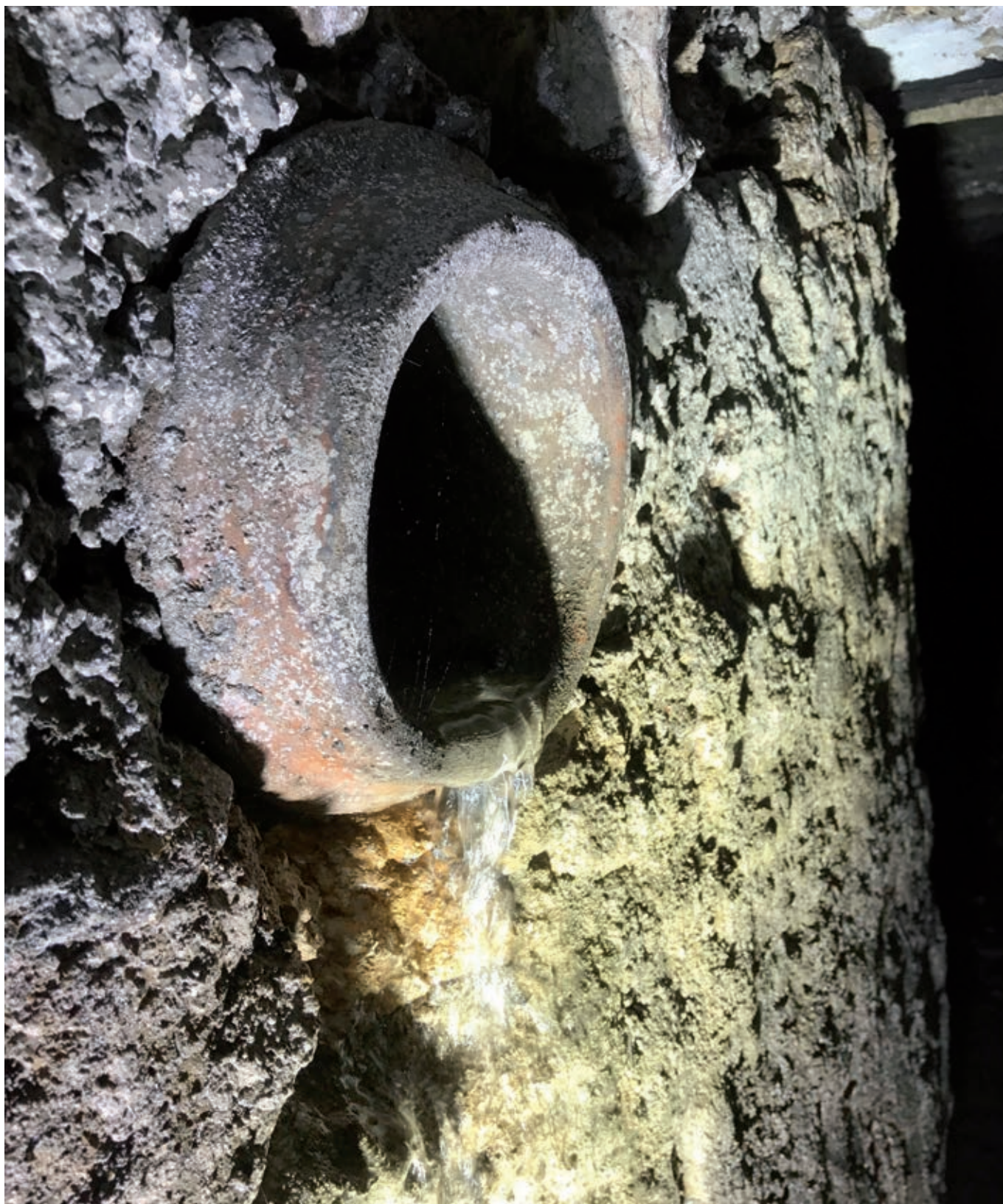
Fig. 15 – Particolare della condotta in laterizio (foto A. Schatzmann). Fig. 15 – Detail of ceramic tube (photo A. Schatzmann).
