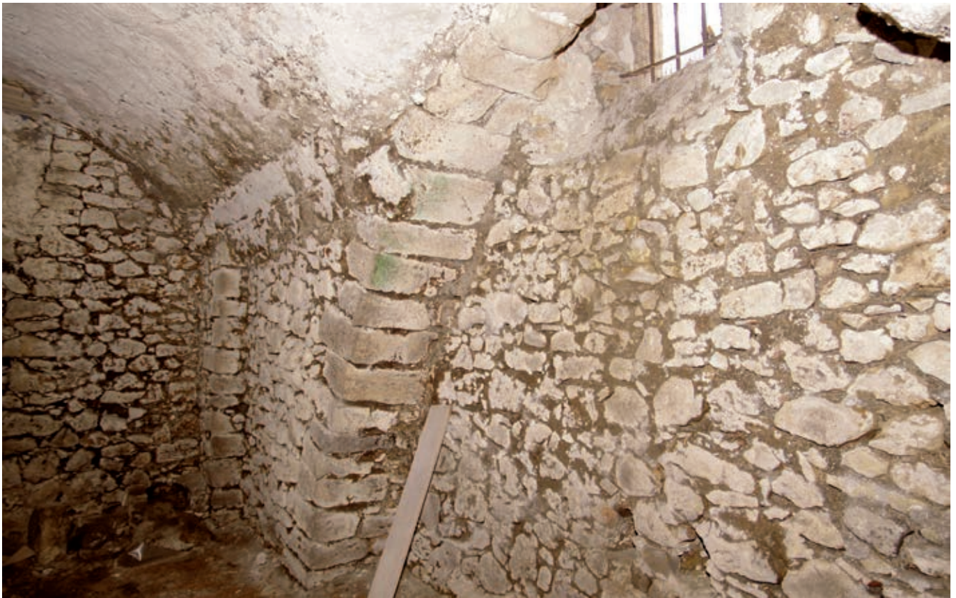
Fig. 31 – Ipogeo sotto al negozio di Corso Vittorio Emanuele 214: tamponature murarie sotto alla finestra (foto C. Germani). Fig. 31 – Underground room under the shop at Corso Vittorio Emanuele, 214: walling up beneath the window (photo C. Germani).
