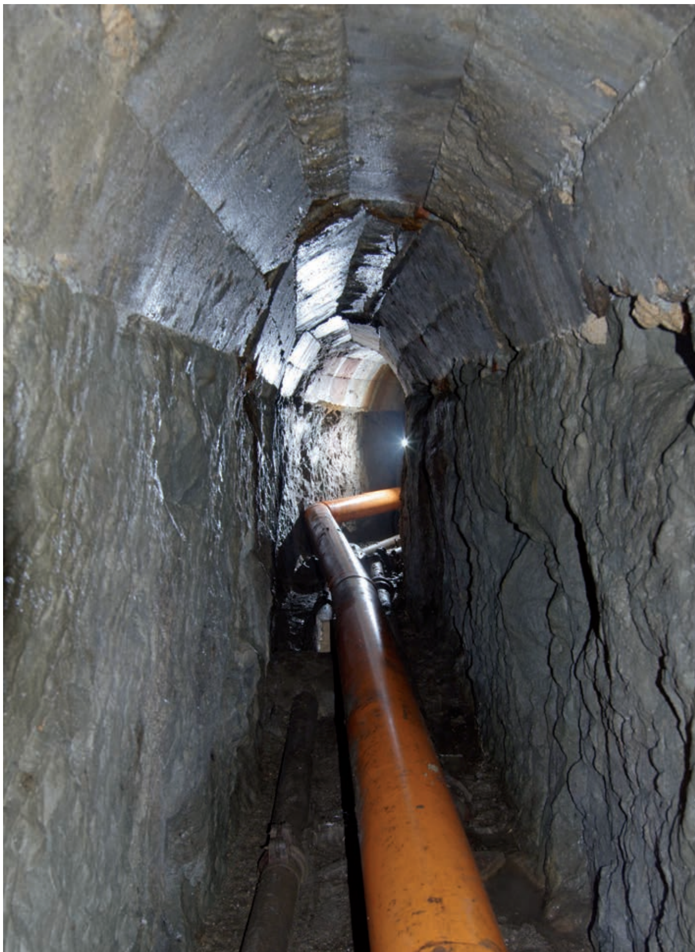
Fig. 26 – Cunicolo sotto l'orto dei Canonici (foto C. Germani). Fig. 26 – Tunnel under the canon's garden (photo C. Germani).
