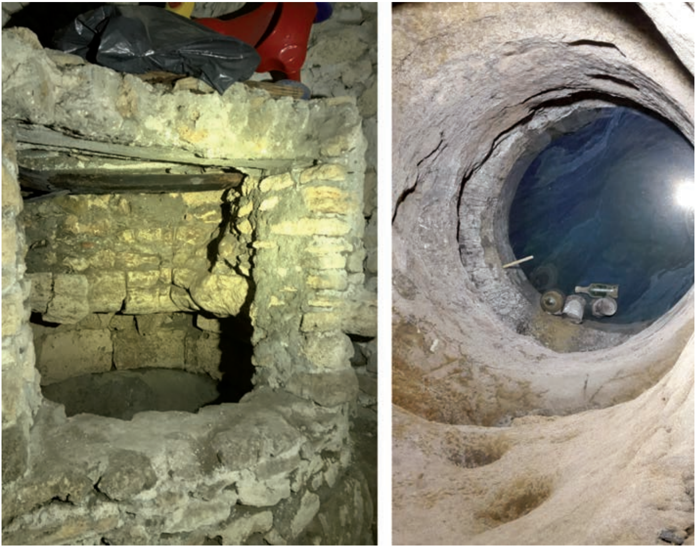
Fig. 8 – Il pozzo nel quartiere San Nicola (a sx foto A. Schatzmann) e interno con pedarole (a dx foto C. Galeazzi). Fig. 8 – The well in the San Nicola district (left photo A. Schatzmann), and its interior with footholes (right photo C. Galeazzi).
