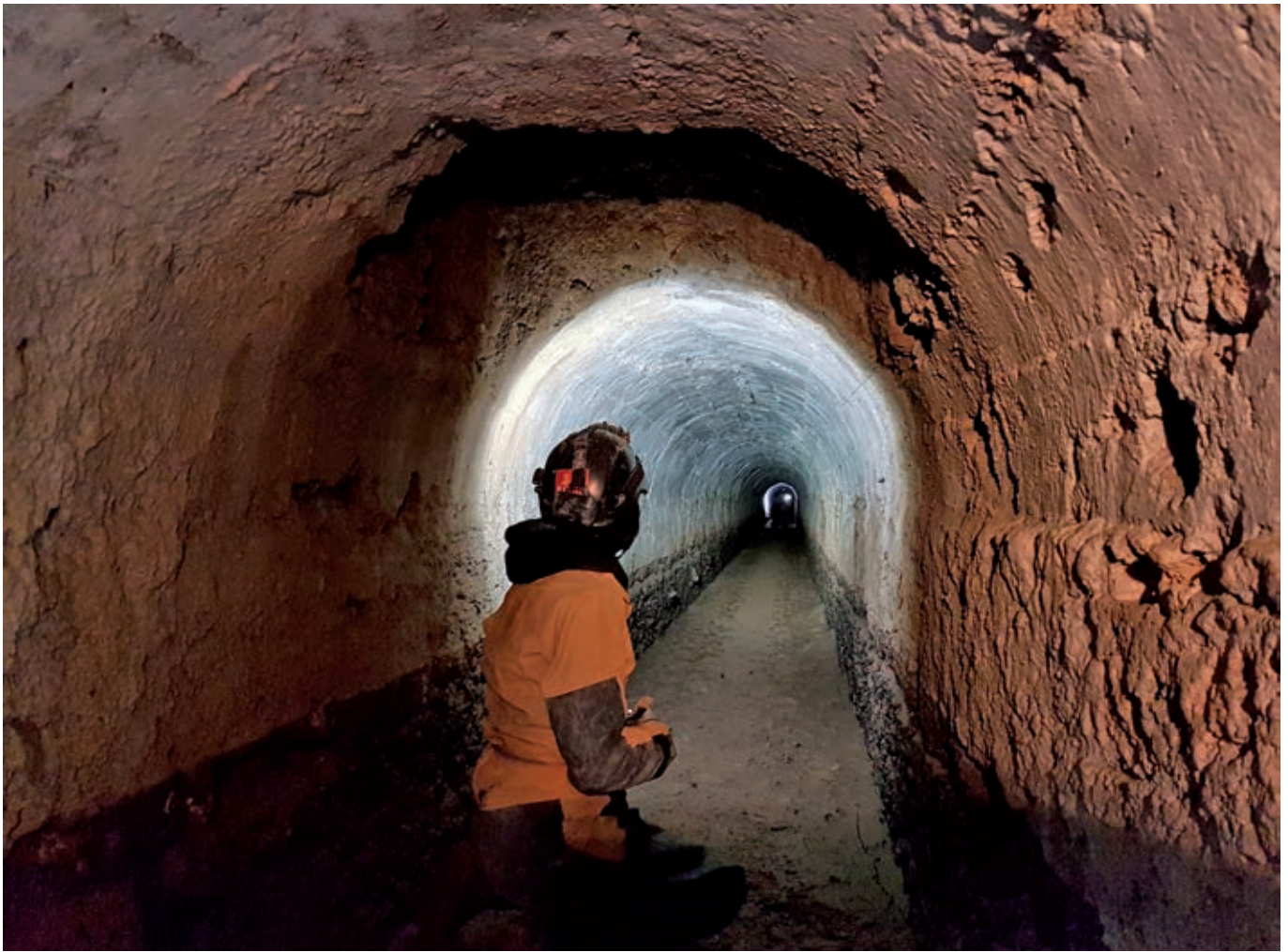
Fig. 10 – Acquedotto La Sala: il ramo sotterraneo (foto C. Fortunato).
